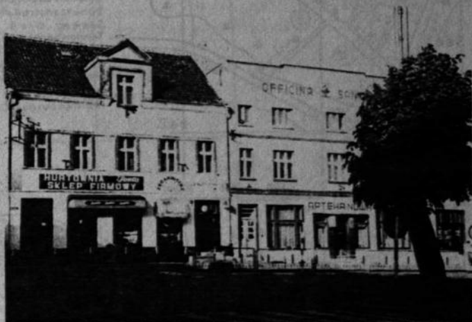
Links das Sparkassengebäude, rechts daneben das Haus, in dem zuletzt das Kino untergebracht war.
